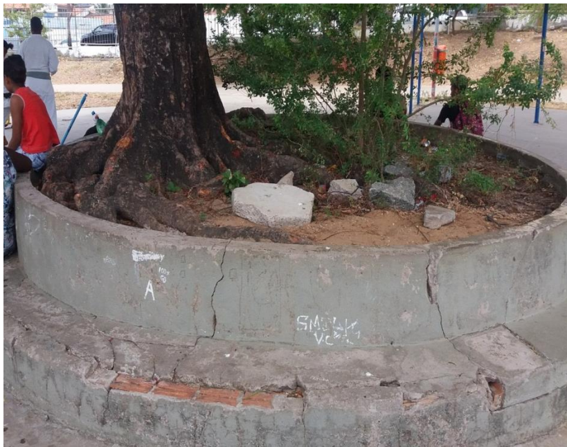
Figura 31. Espécie Aderanthera pavonina causando danos ao canteiro, devido seu tamanho reduzido e má localização, Parque do Bom Menino São Luís-MA.
