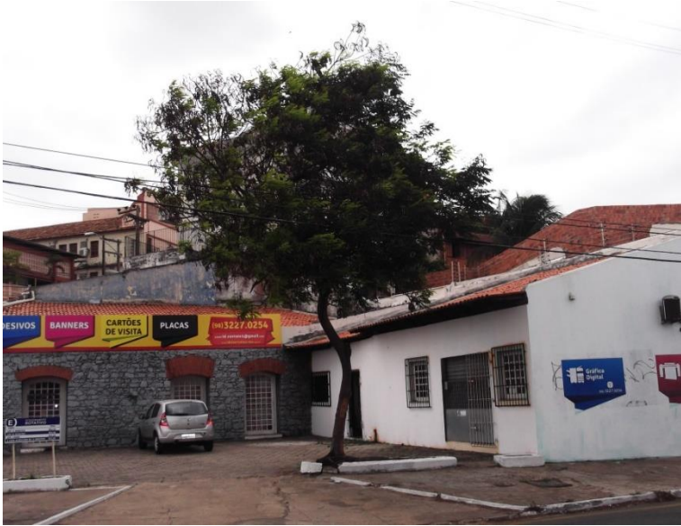
Figura 15. Fiação passando no meio da copa da árvore olho de pombo ( Adenanthera pavonina L.) localizada na Avenida Beira Mar em São Luís - MA.
