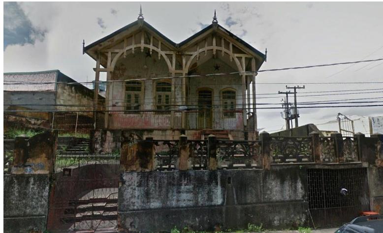
Figura 12: chalé na Av. Getúlio Vargas, 1.948, Monte Castelo. Fonte: acervo do Autor, 2019.
