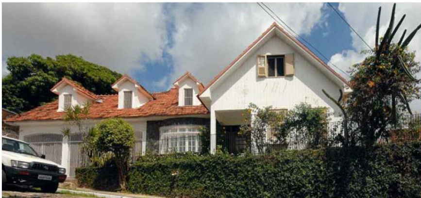
Figura 11: residência Lacroix; Rua do Navio. Fonte: Guia de Arquitetura e paisagem, São Luís Ilha do maranhão e Alcântara.
