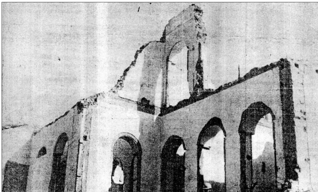
Figura 9 – Casarão em demolição. Fonte: Jornal O Estado do Maranhão de 12/05/1985
