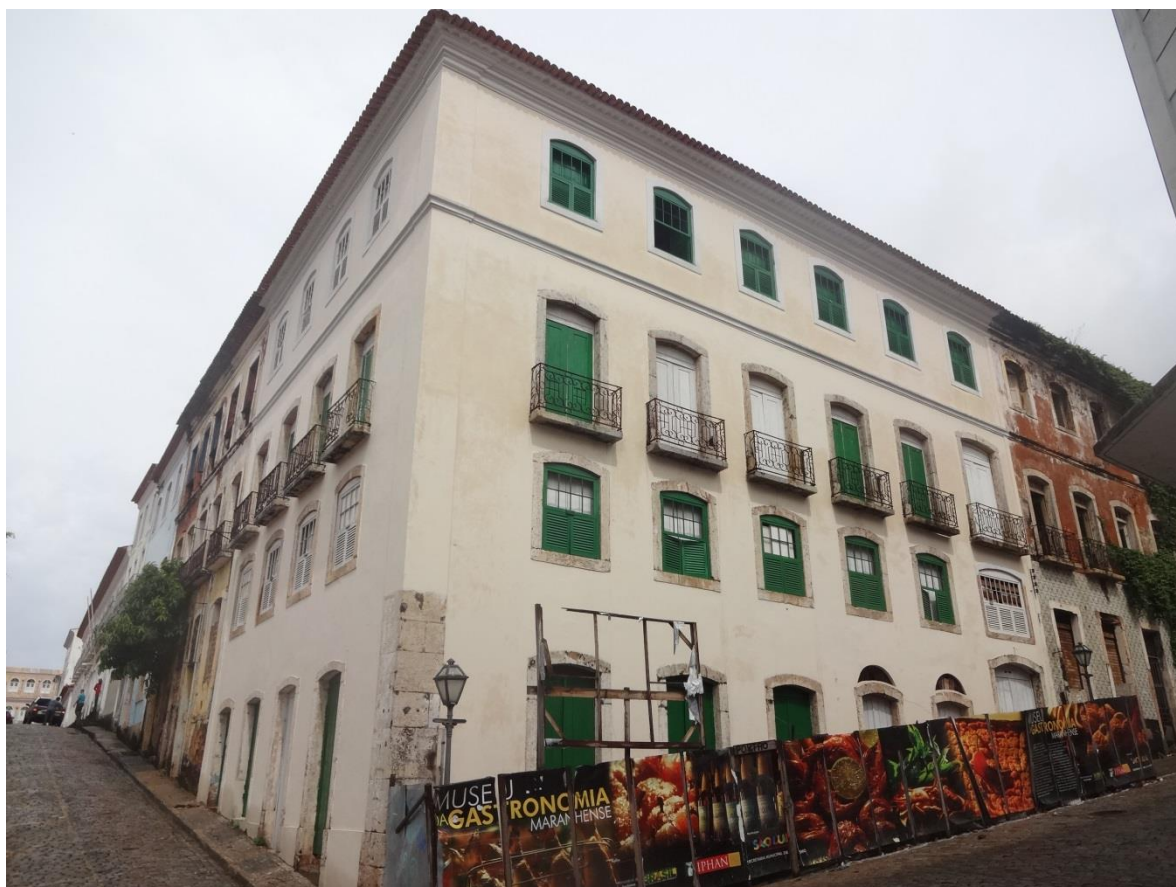
Figura 25 – Restauração de imóvel para utilização como museu. Fonte: Autoria própria
