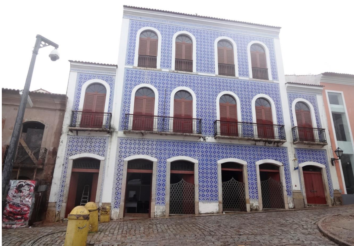
Figura 24 – Casarão restaurado. Fonte: Autoria própria
