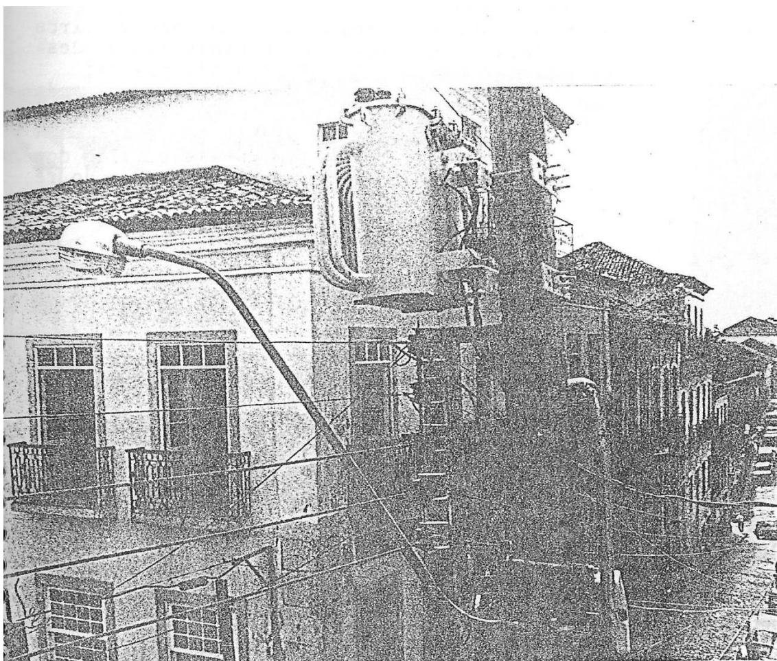
Figura 14 – Fiação elétrica aérea. Fonte: Maranhão, 1986, p. 86
