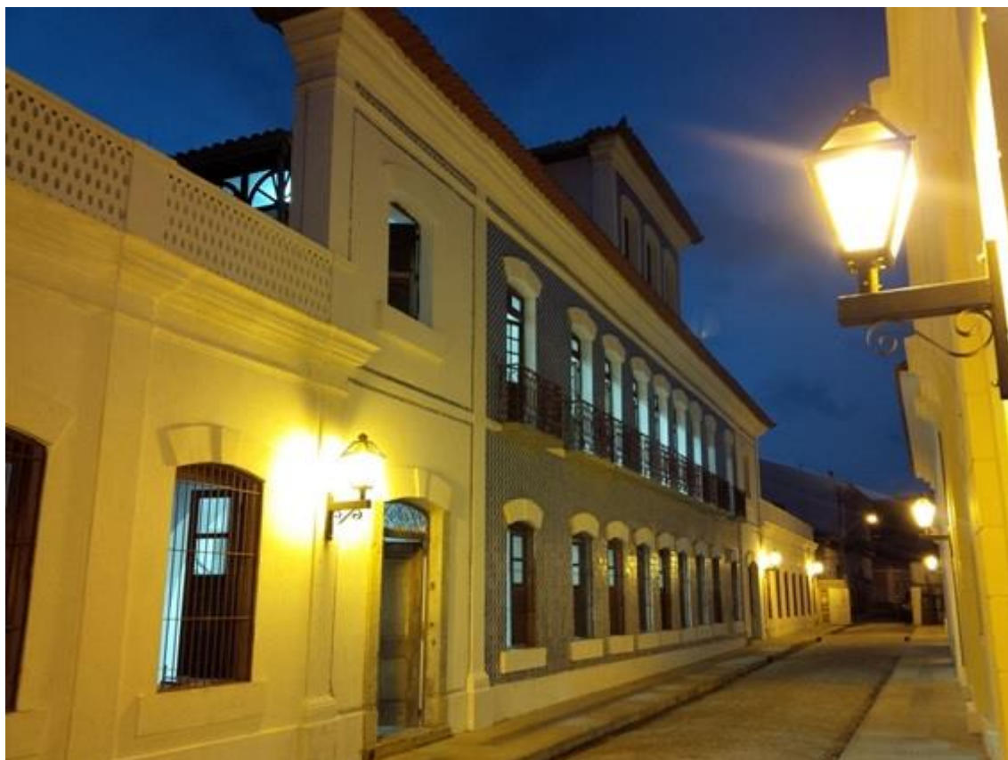
Figura 22 - Fábrica Santa Amélia restaurada (2015). Fonte: http://portal.iphan.gov.br/noticias/detalhes/3316/fabrica-santa-amelia-restaurada-e-entregue-em-outubro
