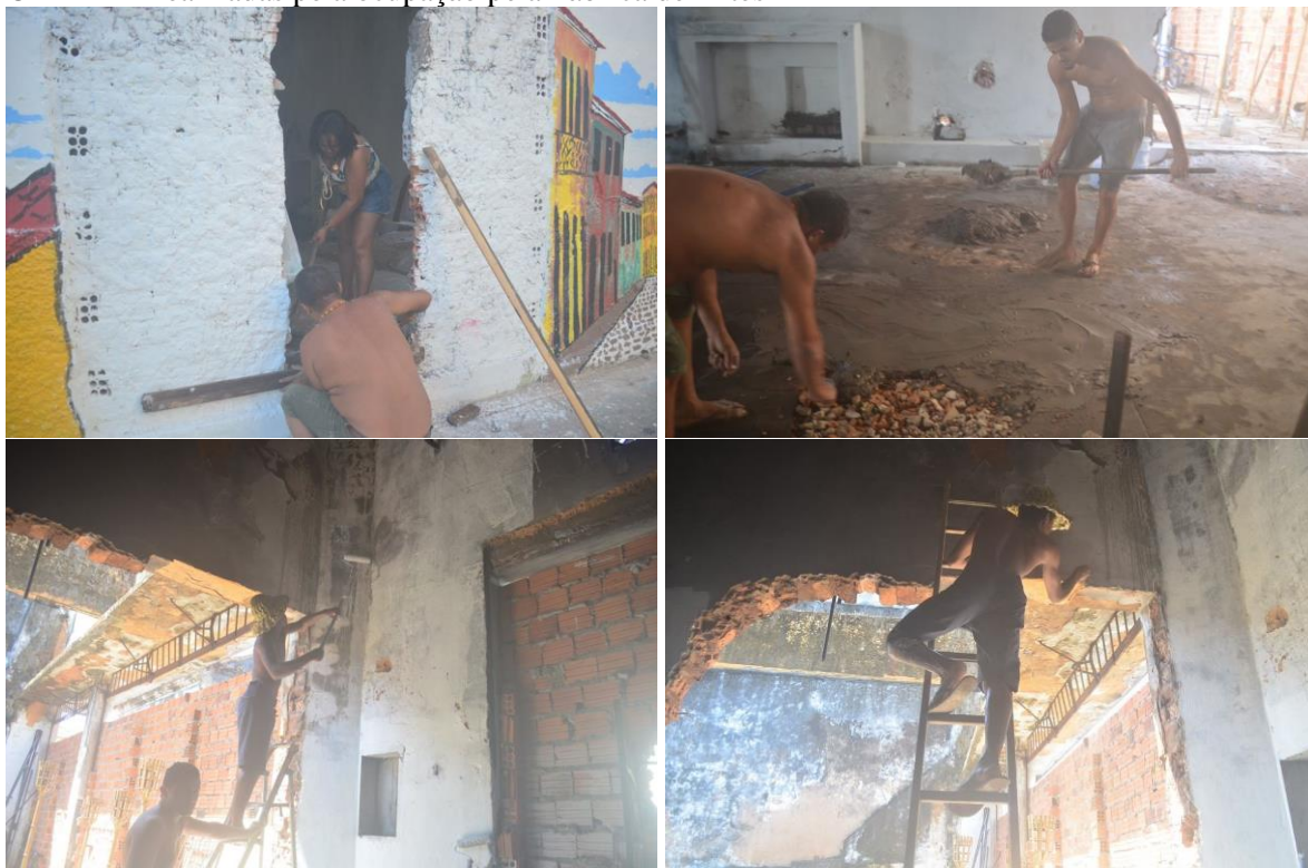
Figura 31 – Fotomontagem com as intervenções estruturais de manutenção do prédio da antiga OLEAMA realizadas pela ocupação pela Fábrica de Artes
